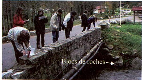
En hiver la rivière est profonde (90cm d'eau) le courant est fort. La rive concave a été consolidée par des blocs de granite ce qui permet d'éviter l'érosion.
