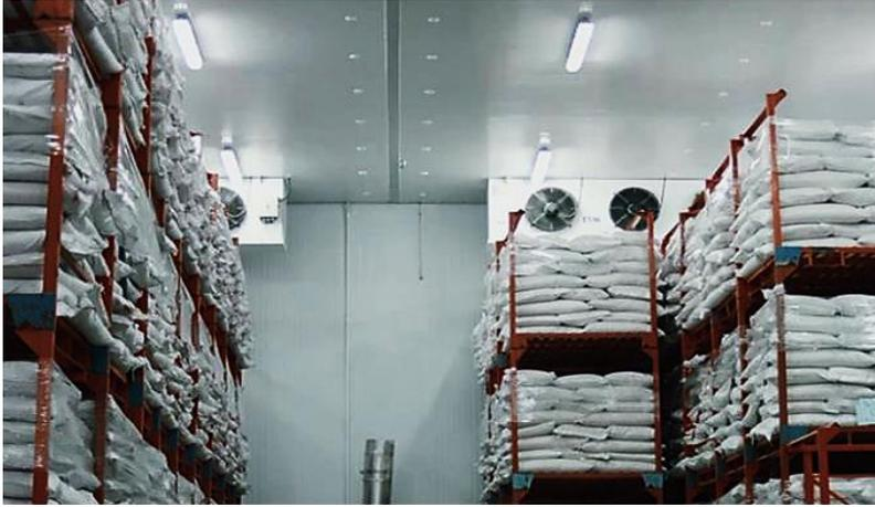
Dans un centre commercial, la conservation de poisson est assurée par une chambre froide à température négative en panneaux démontable de 4m x 4,40m x 2,43m équipé d'une porte coulissante de 1m x 2m.
